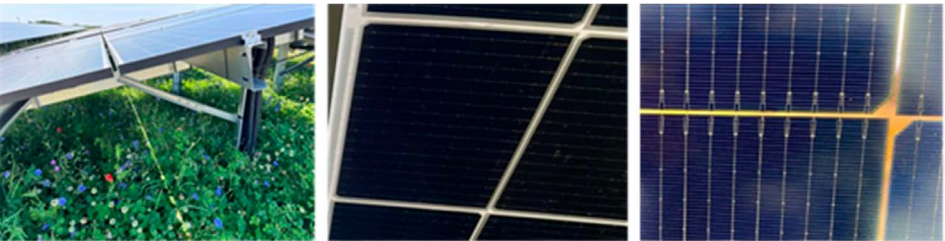
Figuur 8.5. Links: spleten tussen panelen. Midden: niet-transparant bifacial paneel met witte folie tussen zonnecellen. Rechts: deels-transparant bifacial paneel met transparante openingen tussen de zonnecellen.
